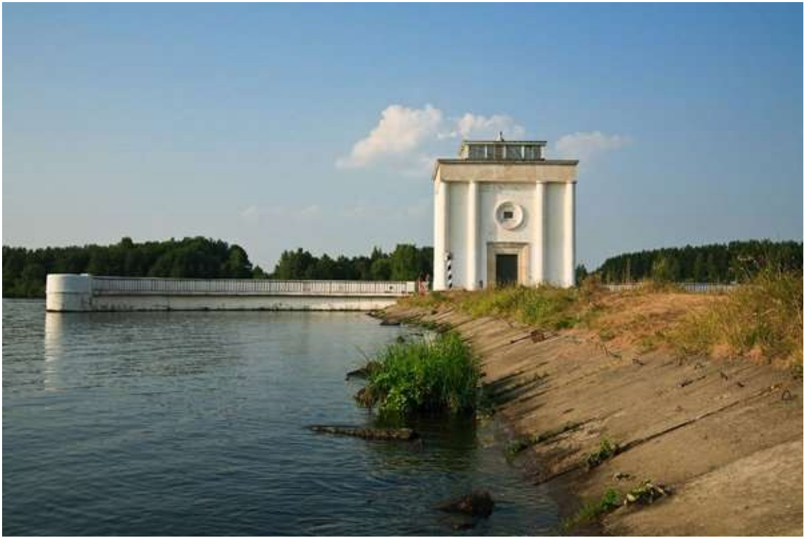
Современный вид гидротехнического сооружения на Икшинском водохранилище канала Москва-Волга
